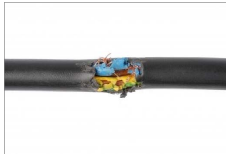
Elektrisk ledning skadet
