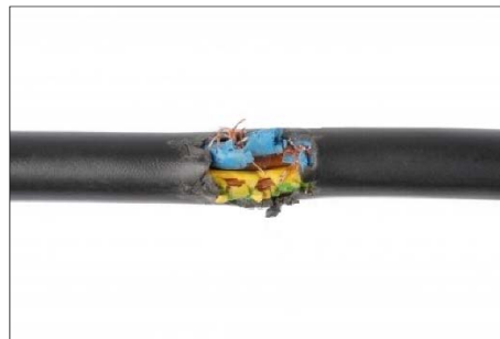
Elektrisk ledning skadet
