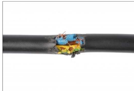
Elektrisk ledning skadet
