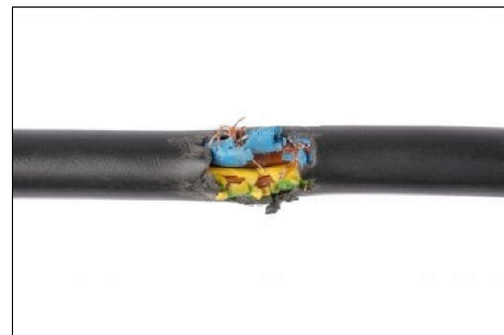
Elektrisk ledning skadet
